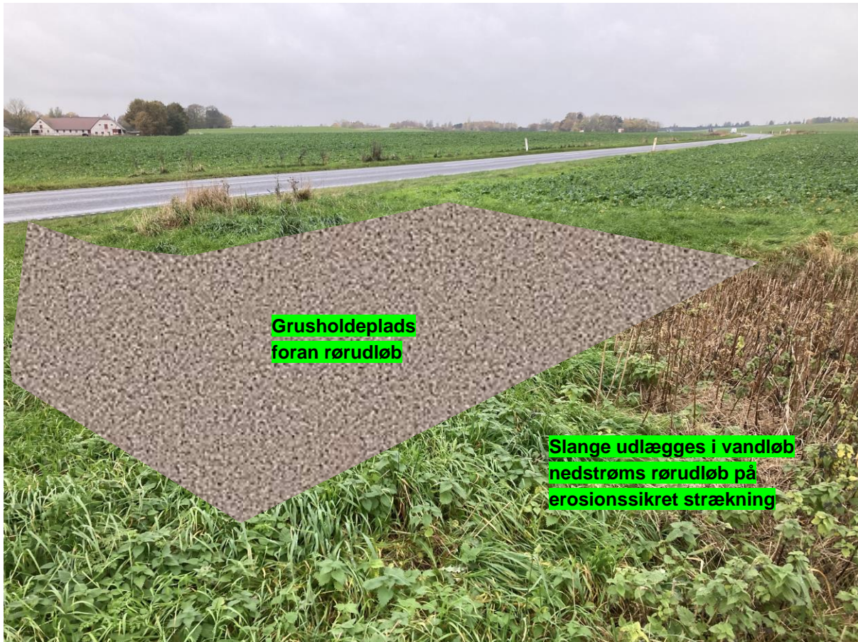
Foto 1. Etablering af indkørsel til udpumpningssted nedstrøms krydsning af Kollerødvej.
