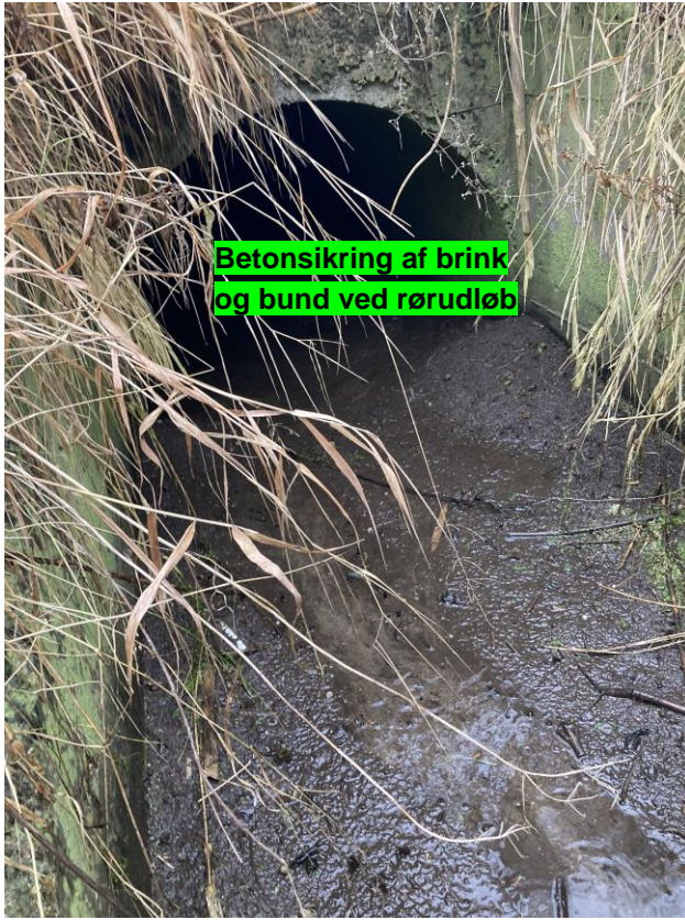
Foto 2. Rørdløb under Kollerødvej med brinksikring.
